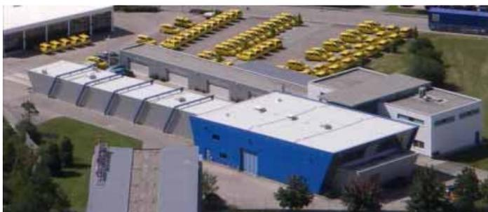
Im November 1999 eröffnet der ADAC nach acht Monaten Bauzeit seine eigene Crashanlage. Die Anlaufstrecke ist 168 Meter lang, davon 72 Meter überdacht. Es lassen sich Unfälle bis zu einer Geschwindigkeit von 120 km/h (bei 3,5 Tonnen Fahrzeuggewicht) simulieren.
