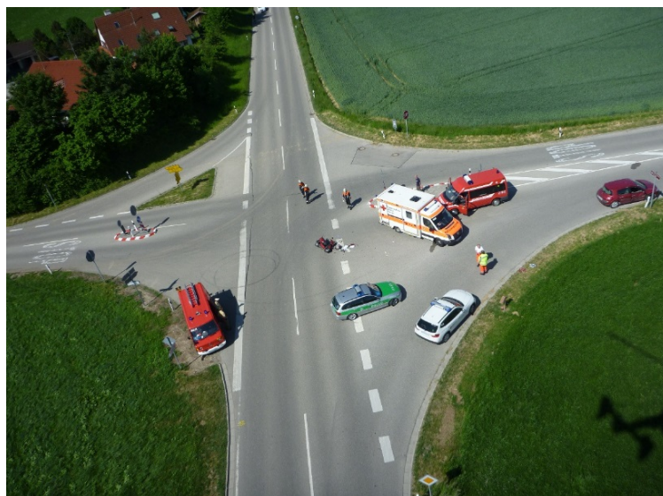
Bild 7: Übersichtliche, gefährliche Landstraßenkreuzung
