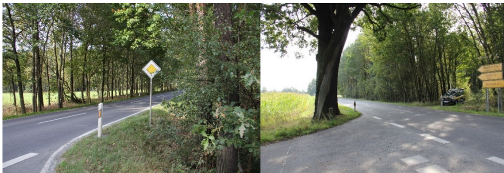
Bild 8: Unübersichtliche, gefährliche Landstraßenkreuzung
