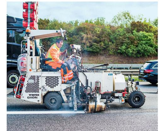
**Malerarbeit** Nach der Trocknung des alten Streifens wird eine neue Linie in drei Millimetern Stärke aufgespritzt
