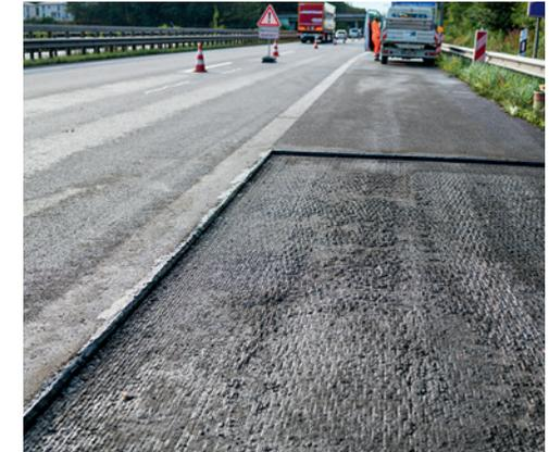
**Ausbesserungsarbeit** Auf dem Standstreifen brannte ein Fahrzeug aus – nun müssen 20 Quadratmeter neu asphaltiert werden
