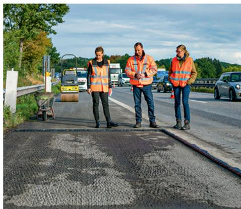
**Abtragung** Von der beschädigten Oberfläche werden 4,5 Zentimeter entfernt, mit Gussasphalt gefüllt, abgesplittet und abgewalzt
