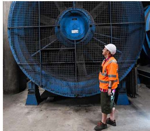
Die komplette Lüftungs- und Steuerungstechnik wird im laufenden Betrieb ausgetauscht
