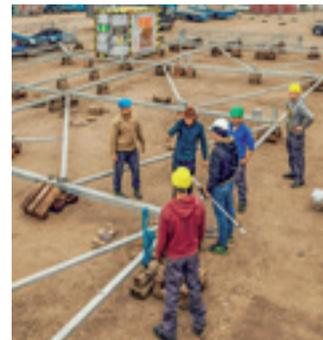
**Grundgerüst:** Ein Gitternetz gleicht beim Aufbau Unebenheiten aus
