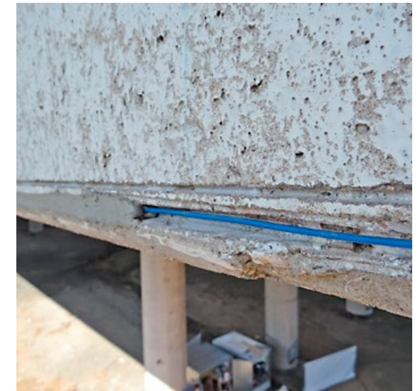
Ein Glasfaserkabel leitet ein Signal durch die Brücke. Das Team erkennt bei der Auswertung, ob und wo neue Risse entstanden sind
