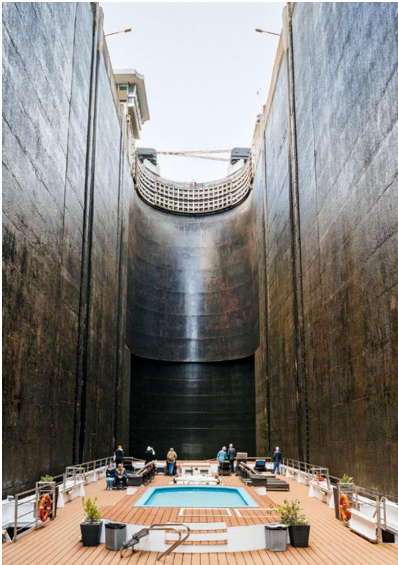
Lichtschacht Die Carrapatelo-Schleuse hat eine Fallhöhe von maximal 35 Metern
