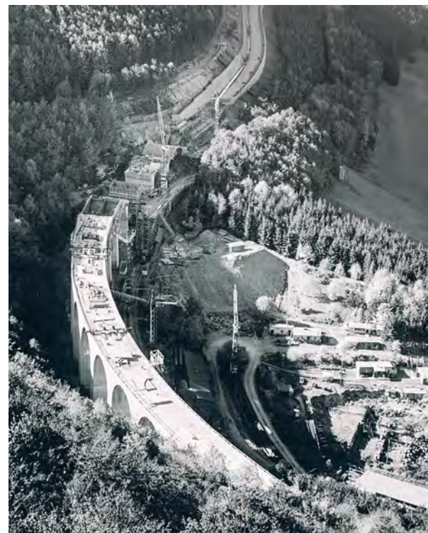
Links Historisches Foto von 1937, Blick auf die Baustelle vom Hang der Stuttgarter Seite auf die Todsburgbrücke.
