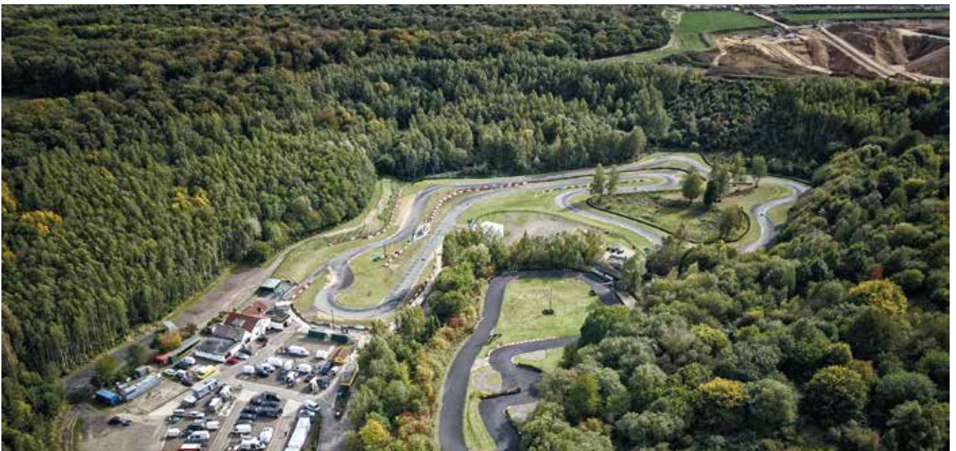
Der Erftlandring Kerpen – Bagger in der Nachbarschaft.
