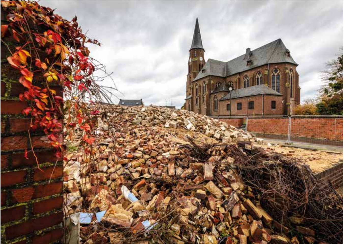
Abriss für den Tagebau in Kerpen-Manheim.
