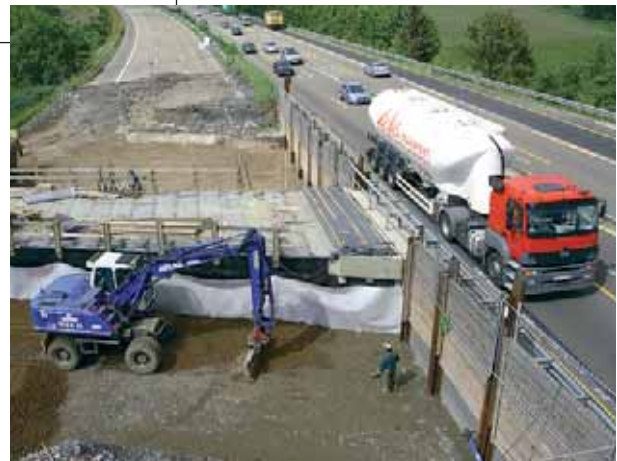
Erneuerung eines Brückenbauwerks
