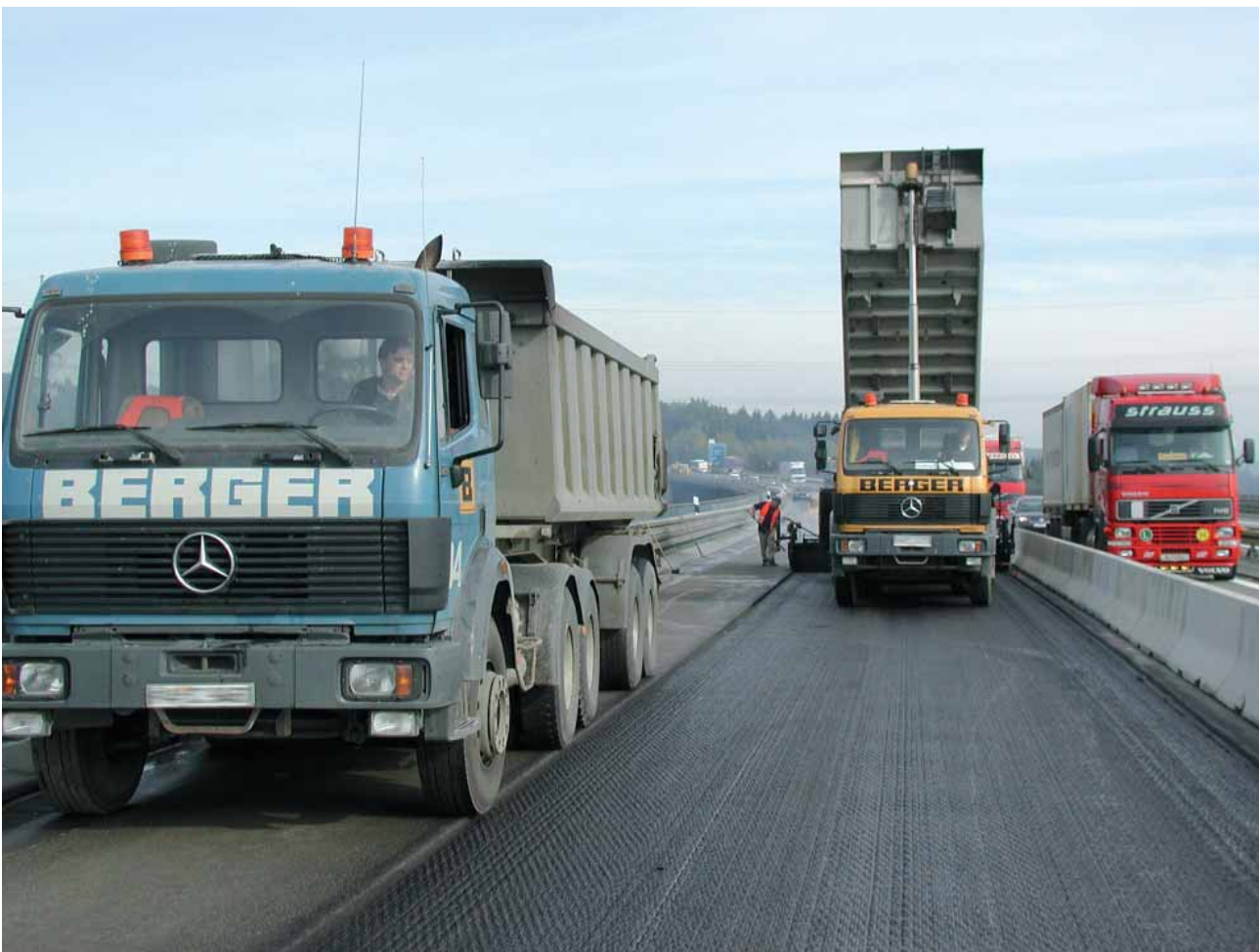
Fahrbahnsanierung auf Autobahn (Quelle: Ing. Büro Wagmann, Fürstzell)
